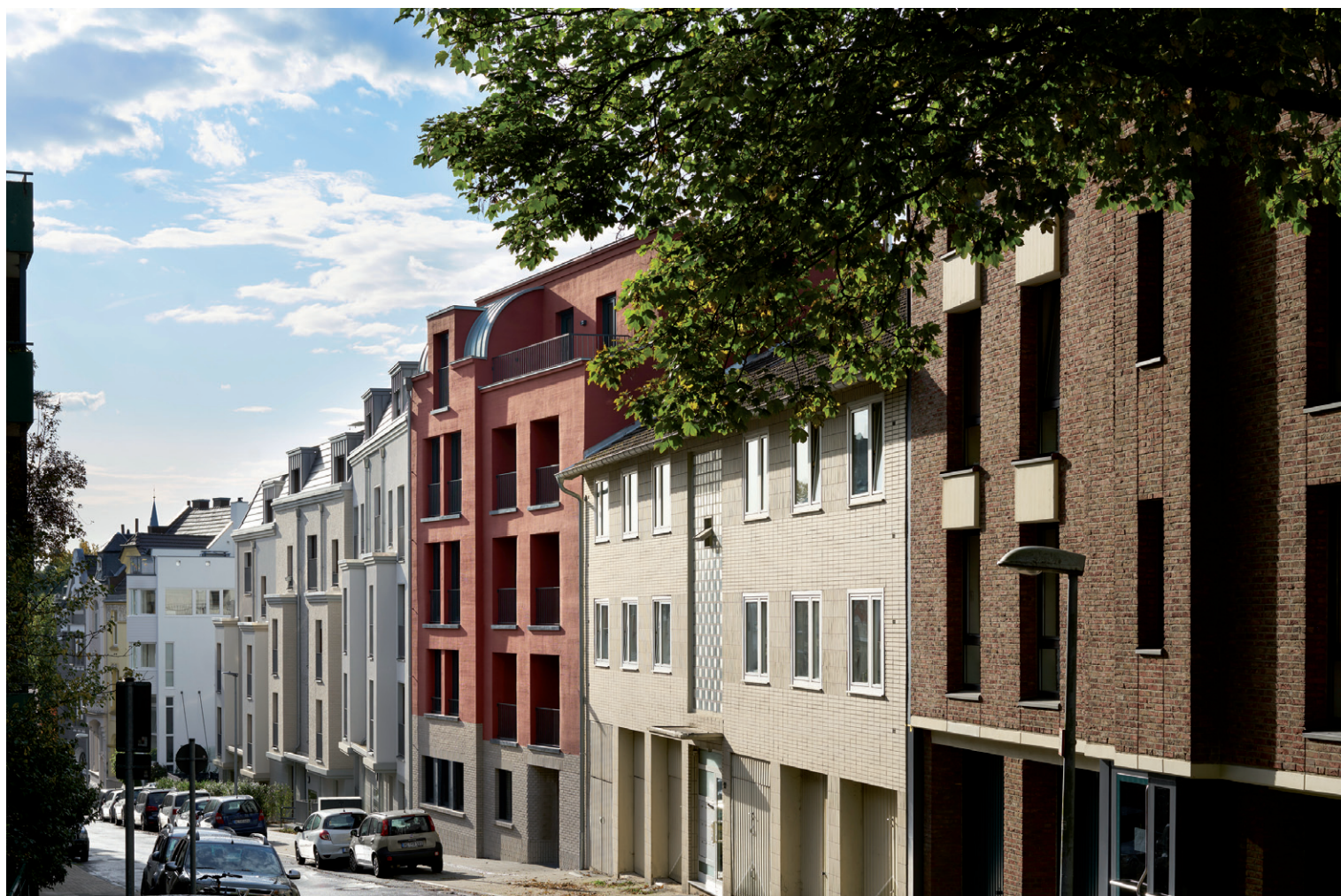
Der Neubau schließt eine Baulücke und vermittelt zwischen den bestehenden Baufluchten. Il nuovo edificio riempie un vuoto con una altezza intermedia tra le linee di gronda degli edifici esistenti.
